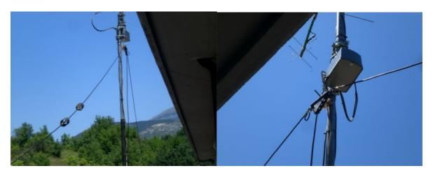
Per le prove e test il centrale del dipolo e' stato agganciato momentanamente sulla base del rotore delle mie antenne satellitari, un palo sul balcone di casa alto circa 5 metri, i bracci sono stati ancorati sui passamano dei balconi tramite cordicella plastica di 7 mm di diametro.
